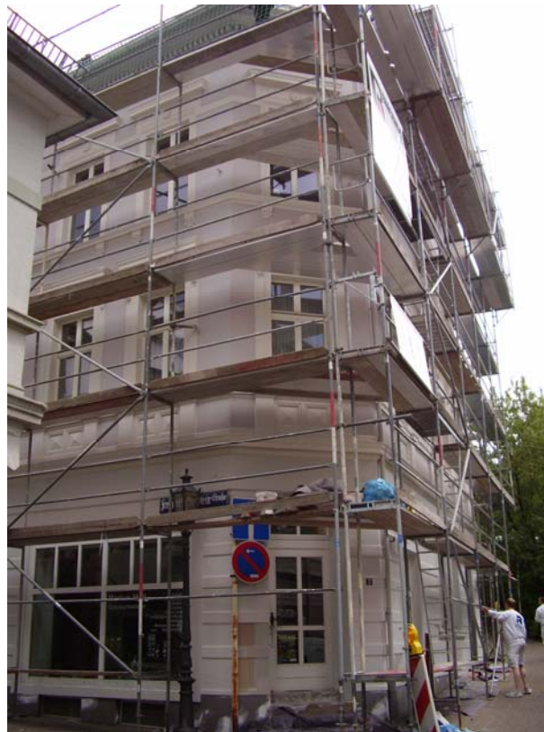
Reparaturen und Renovierungen haben bezüglich Werkstoffwahl, Farbgestaltung und Konstruktion der Erhaltung und Gestaltung des historischen Stadtbildes zu dienen
