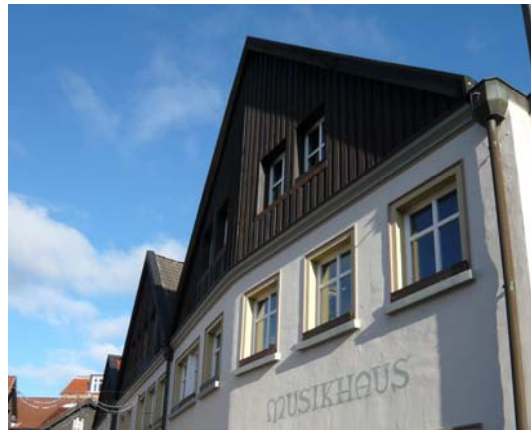
Beispiel einer Holzverkleidung im Giebel, Ringmauerstraße 10
