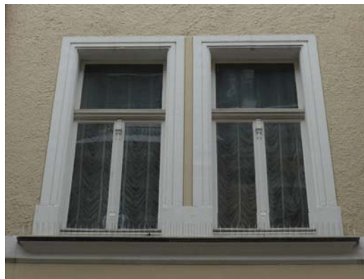
Fensterunterteilung mittels Mittelpfosten und Kämpfer
