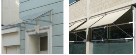
Beispiele von einem Glasvordach und eine Markise.
