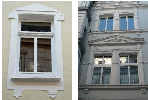
Beispiele von Fenstern mit Fensterfaschen.
