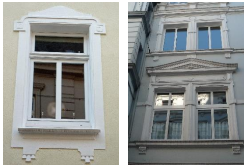
Beispiele von Fenstern mit Fensterfaschen.
