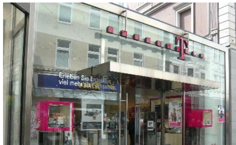
Vordach, architektonisches Element im Gesamtkonzept.
