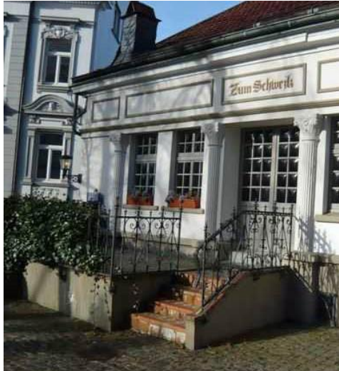
Freitreppe zum Gebäude am Beispiel des Gasthauses Schweißk.
