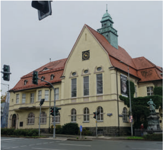
ALTES AMTSHAUS FREIHERR-VOM-STEIN-STRASSE
