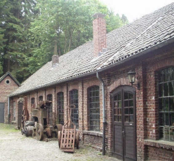
BREMECKER HAMMER: FRÜHINDUSTRIELLER ZEUGE QUELLE: STADT LÜDENSCHIED
