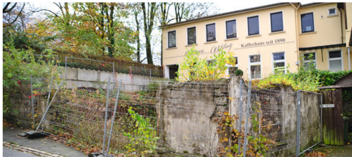
RUINE DES ALTEN PASTORATS, HEUTE QUELLE: STADT LÜDENSCHIED
