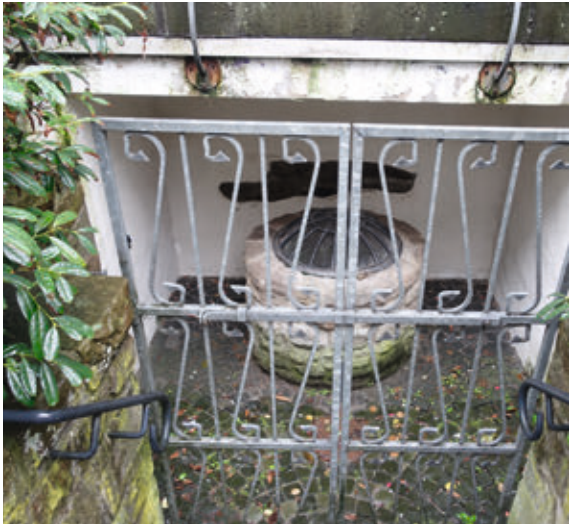
1: WASSERSTELLE AM GEBÄUDE LUISENSTRASSE 3/5
