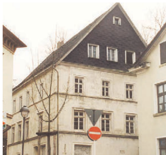
LOHER STRASSE 2, EHEMALS PASTORAT „AUF DER LINDE“, 1995 QUELLE: GHV E.V. LÜDENSCHIED
