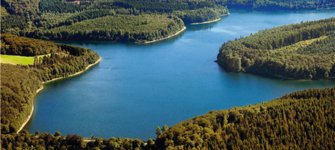
VERSETALSPERRE QUELLE: STADT LÜDENSCHIED
