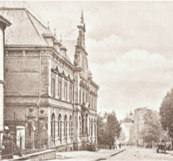
ALTE POST 1893 QUELLE: STADT LÜDENSCHIED
