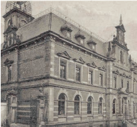
EHMALIGES POSTGEBÄUDE, UNDATIERT QUELLE: STADT LÜDENSCHIED (AUSSCHNITT)
